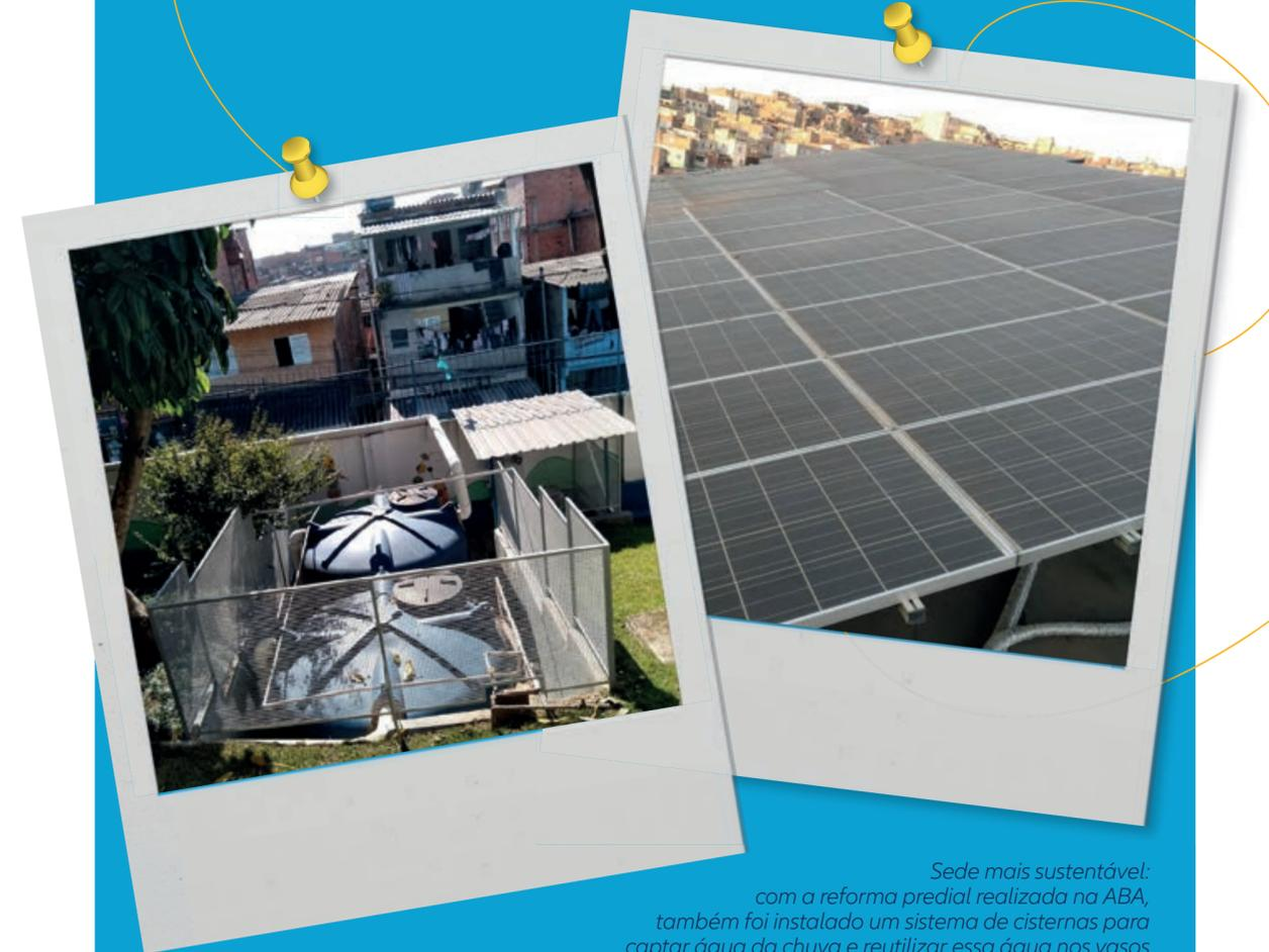
*Sede mais sustentável: com a reforma predial realizada na ABA, também foi instalado um sistema de cisternas para captar água da chuva e reutilizar essa água nos vasos sanitários. Além disso, foram colocadas placas solares, que transformam a luz do sol em energia elétrica, uma ação permanente e responsável de respeito à natureza*
